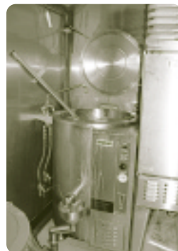
> La cuisine dispose d'une bouilloire à chemise (steam pot) pour cuire les sauces et les soupes en grande quantité (CPE Saint-Luc).
