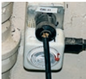
Isolation du fil électrique déficiente et absence de la troisième branche de mise à la terre : des situations à corriger immédiatement.
