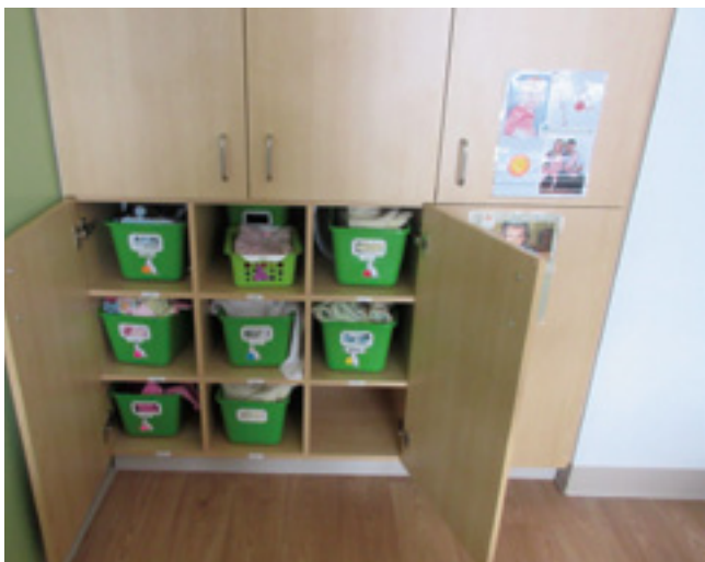
Les casiers de l'armoire encastrée sont accessibles par les parents dans le corridor et par les éducatrices dans le local.
