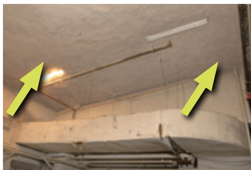
Flocage au plafond.
