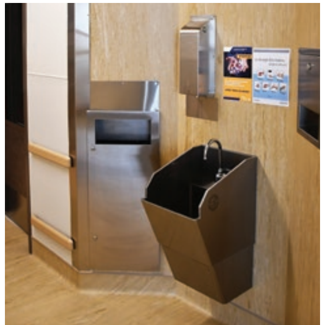
Zone de lavage des mains
