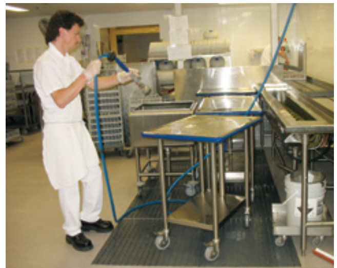
Un système de drainage au sol dans toute la zone des postes de débarassage est recouvert de sections amovibles et antidérapantes. Cet espace est utilisé lors du nettoyage de la vis sans fin, du convoyeur de paniers et des tables sur roulettes.
