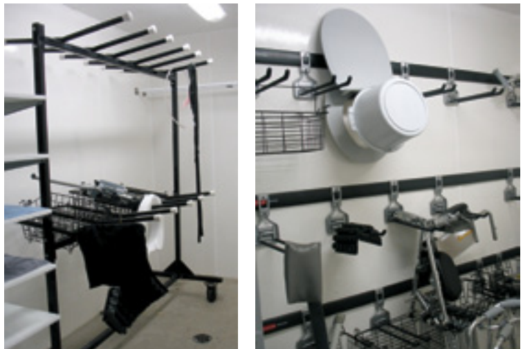
1. La chambre de lavage comporte un boyau d'arrosage, un drainage au plancher et un système de supports pour permettre le séchage des petites pièces.
