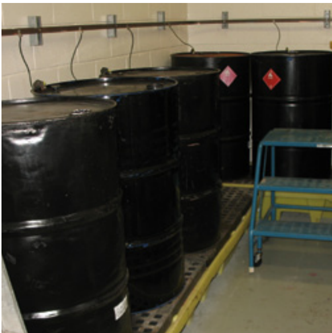
Entreposage de matières inflammables avec mise à la terre et bacs de rétention.
