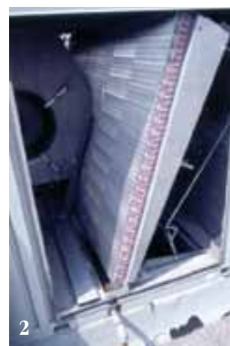
1. Entrée d'air et filtres bien entretenus. 2. Serpentins de refroidissement bien entretenus.
