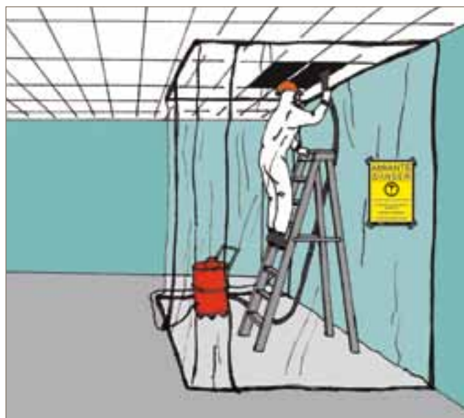
Enceinte de travail isolée pour accéder à une zone avec de l'amiante friable. © ASP Construction
