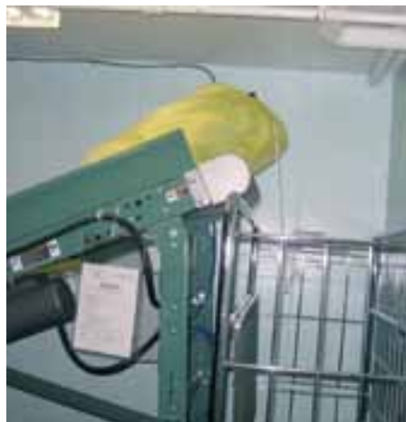
6. Les dégagements aux sections inférieure et supérieure du convoyeur sont adéquats. L'angle du convoyeur et le type de recouvrement de la courroie permettent le déplacement des poches vers le chariot.
