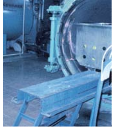
Plateforme qui facilite le traitement des déchets biomédicaux dans le tunnel de vapeur (CSSS de l'Érable-Arthabaska).
